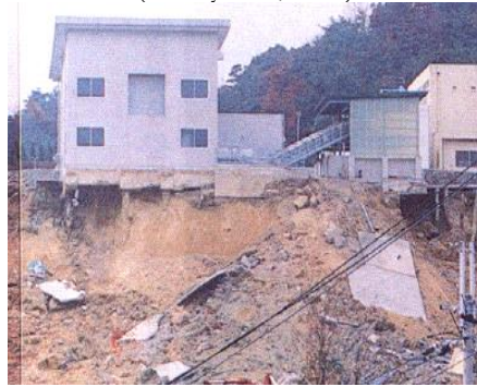
Figura 6. Ejemplo de edificios con peligro geológico o geotécnico.
