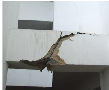
Figura 16. Ejemplos de daños en vigas de concreto armado.
