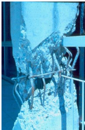
Figura 12. Ejemplos de daños en columnas de concreto armado.
