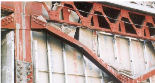
Figura 20. Ejemplos de daños en diagonales de arriostramiento en pórticos arriostrados de acero. El pandeo en el arriostramiento de la izquierda es representativo del desempeño esperado que permite disipar energía por ese mecanismo.
