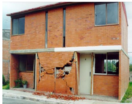
Figura 22. Ejemplos de daños en edificios de mampostería estructural.
