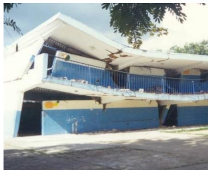
Figura 4. Ejemplos de edificios para la definición de colapso de la estructura.
