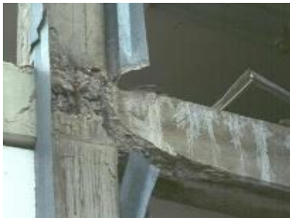
Figura 16. Ejemplos de daños en vigas de concreto armado.
