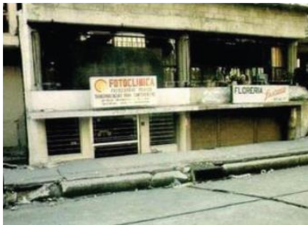
Figura 8. Ejemplos de asentamientos de Edificios.
