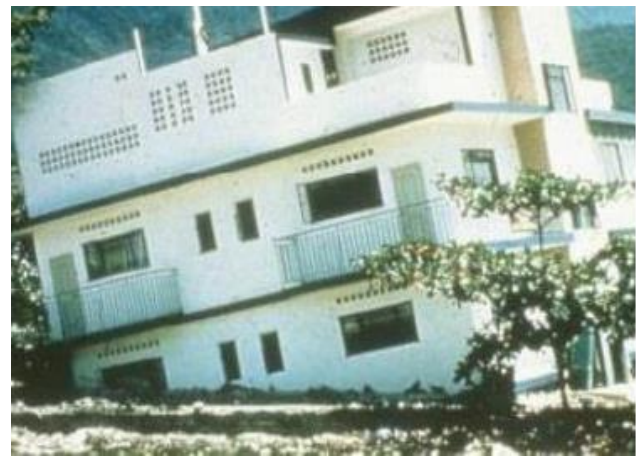
Figura 8. Ejemplos de asentamientos de Edificios.
