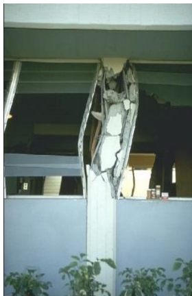
Figura 12. Ejemplos de daños en columnas de concreto armado.
