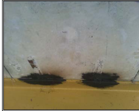
Anexo 4.15.13.- Soldadura Muro-Perfil, planta baja, edificio A.
