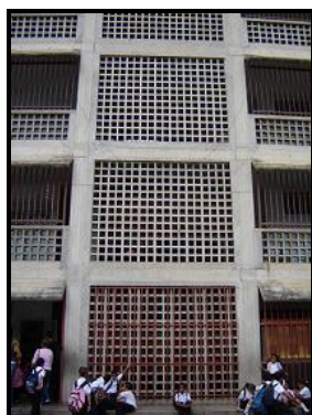
Figura 4.10.22.- Edificio Central o módulo independiente de la escalera. A los lados del mismo se ubican las dos juntas de construcción, mediante las cuales se conectan los dos edificios contiguos: edificio Norte y edificio Sur, U. E. N. Padre Sojo.
