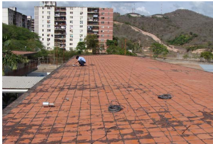
Figura 5.2. 52.- Instalación de los sensores Ch 3 y Ch 4
