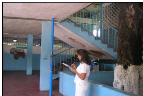
Figura 4.6.59.- Escalera apoyada en uno de los módulos.
