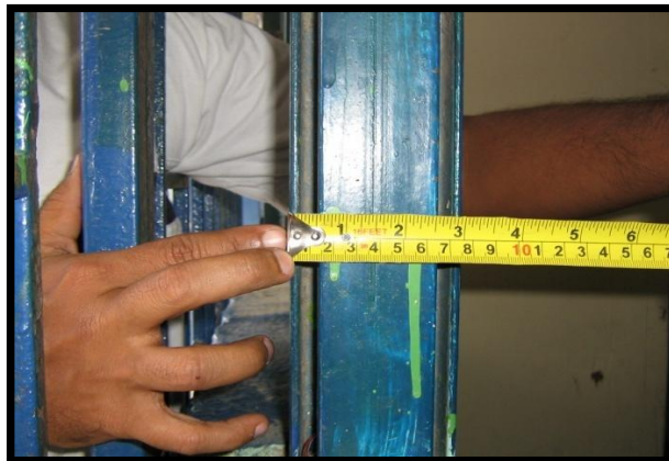
Figura 4.13.7 Edificación 2. Columnas de perfiles tipo IPN80
