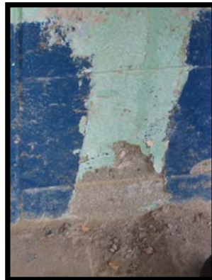
Figura 4.13.2 Mampostería con bloques de concreto
