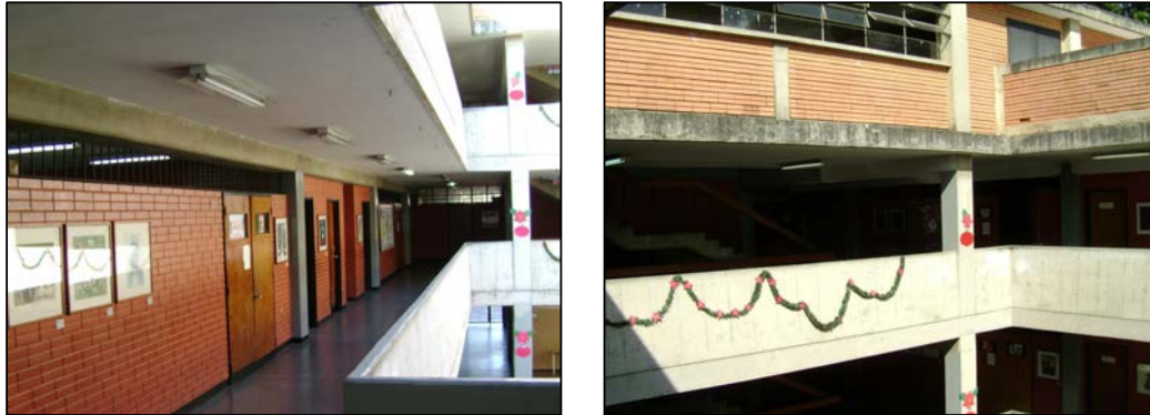
Figura 4.11.5.- Pasillo interno / tercer nivel vista interior.
