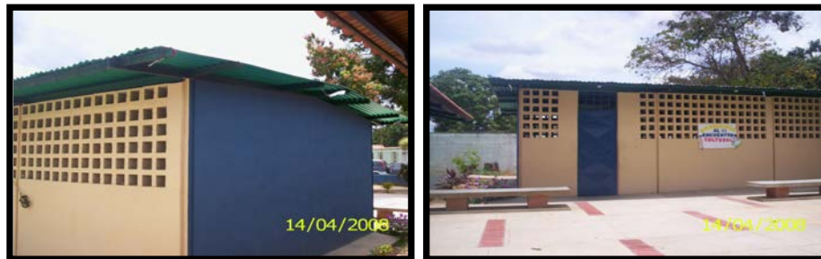
Figura 4.13.19 C.E.I.B. Caja de Agua II, Estado Aragua
