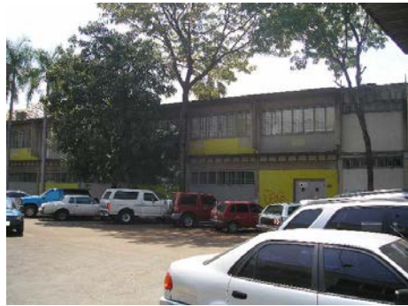
Figura 3.6. Fachada norte del Edificio Sur del IMME
