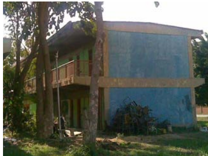
Anexo 4.16.21.- Fachada este del Módulo 4.
