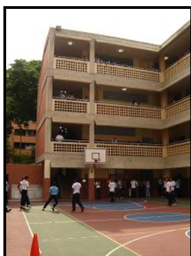
Figura 4.10.10.- A la izquierda se encuentran las escaleras, se observa claramente las diferentes distancias entre ejes. E. B. N. Fernando Peñalver.
