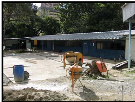
Figura 4.13.3 Edificación 1. Tipo R-4, cubierta láminas metálicas corrugadas
