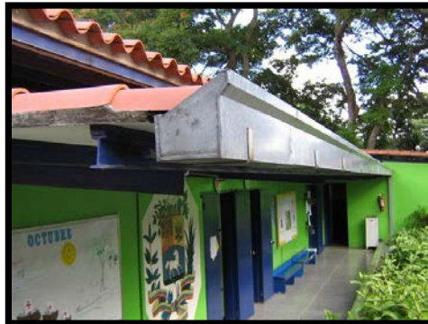
Figura 4.13.12 Edificación 1 pasillo de circulación y techo
