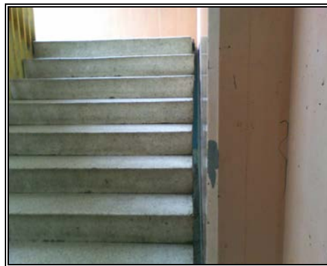
Anexo 4.15.9.- Separación Escalera-Edificio, planta baja, edificio A.
