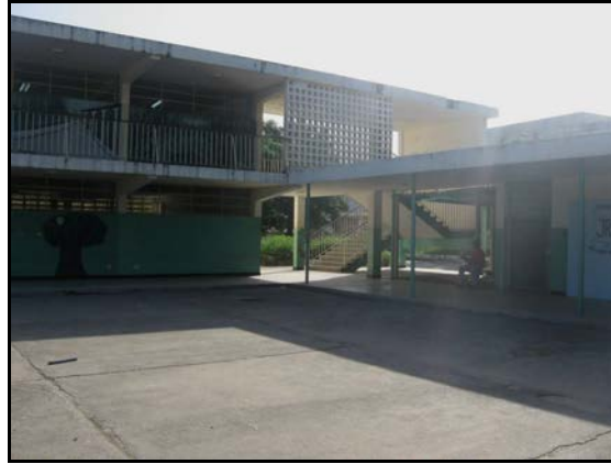
Figura 4.6.35.- Se observa que las escaleras están conectadas al final de cada edificio.
