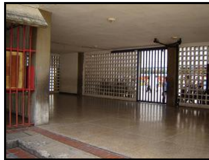
Figura 4.10.17.- Imagen tomada desde el patio central hacia el edificio Norte de la U. E. N. Padre Sojo. Se observa la planta baja libre.
