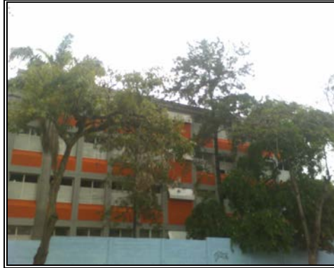
Anexo 4.15.1.- Fachada Norte, edificio A.
