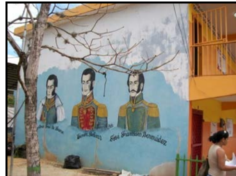
Figura 4.6.11.- Fachada Este y Oeste
