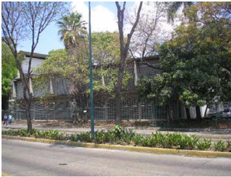
Figura 3.5. Fachada sur del Edificio Sur del IMME
