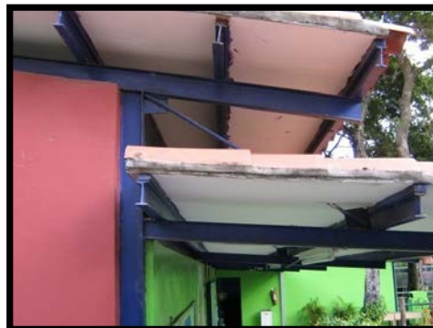
Figura 4.13.13 Edificación 1 Alero de edificación 1 sostenido por tensores de \phi 3/4"
