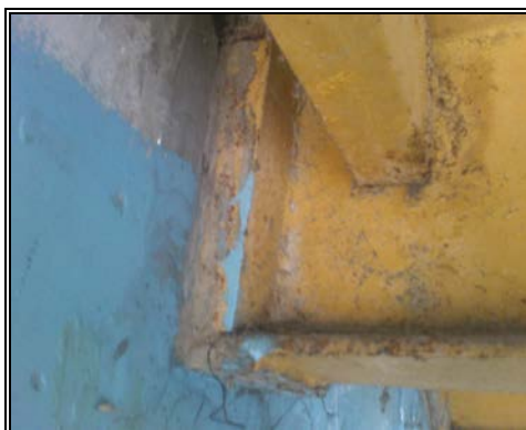
Anexo 4.15.12.- Unión Muro-Perfil, planta baja, edificio A.
