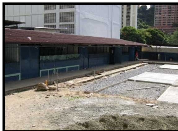
Figura 4.13.6 Edificación 2. Tipo R-4, cubierta láminas metálicas corrugadas
