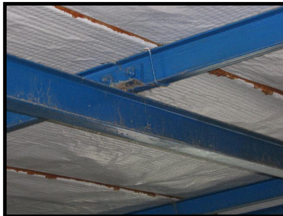
Figura 4.13.5 Edificación 1. Uniones apernadas en techo
