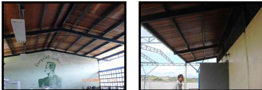
Figura 4.13.34 E.T.I. Cruz Villegas, Estado Miranda
