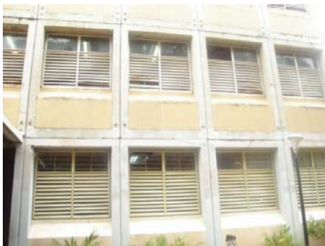
Figura 4.15.21.- Construcción de un edificio con el sistema Variel
