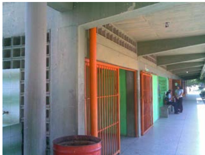
Anexo 4.16.2.- Fotografía Módulo 4, se evidencian las vigas en dirección longitudinal.
