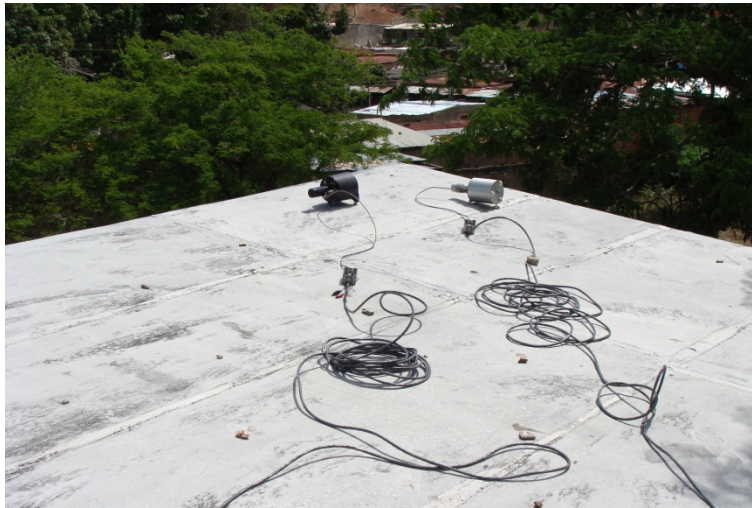
Figura 5.2. 96.- Sensores Ch 1 y Ch 2.
