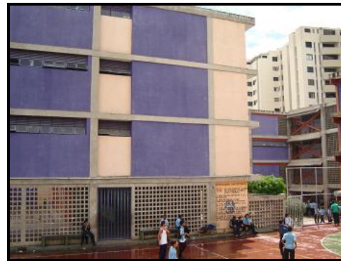
Figura 4.10.3.- Fachada Norte de la U. E. N. Padre Sojo. Se aprecia la dimensión 6,90 m y el volado de 3,40 m. Al fondo se encuentra la U. E. N. Julio Bustamante.
