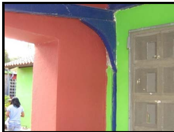
Figura 4.13.16 Edificación 2. Cartelas para soporte de alero
