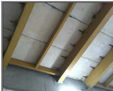
Anexo 4.15.10.- Descanso, vista inferior, planta baja, edificio A.
