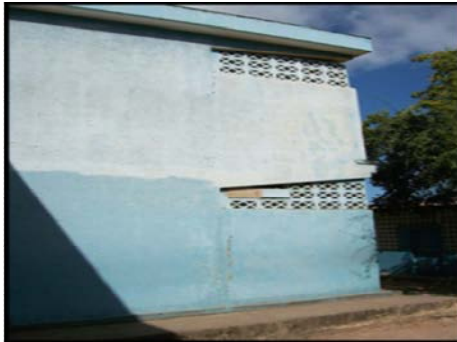
Figura 4.6.5.- Fachada Este y Oeste
