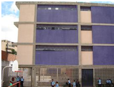
Figura 4.10.16.- Imagen de la Fachada Norte, donde se aprecian los 4 niveles estructurales con dimensiones de 6,90 m. y el volado de 3,40 m. U. E. N. Padre Sojo.
