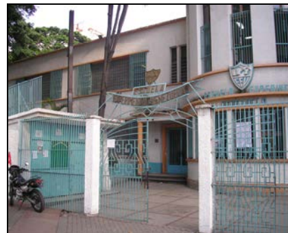
Figura 4.12.10. Fachada principal de la Experimental Venezuela
