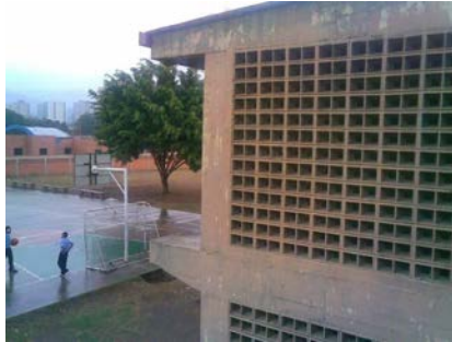
Anexo 4.16.20.- Fachada oeste del Módulo 4.
