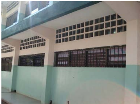
Figura 4.9.3.- Fachada Posterior del Módulo 1
