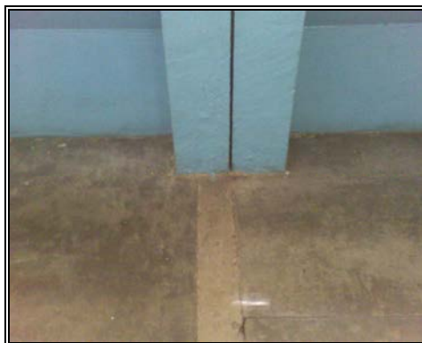
Anexo 4.15.16.- Unión Losa-Columna, primer piso, edificio A.
