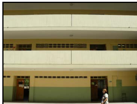
Figura 4.7.6.- Detalle de las losas de entpiso y los antepechos de los pasillos.
