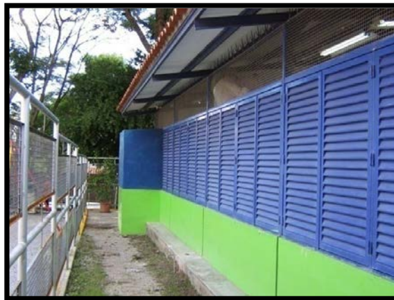
Figura 4.13.15 Edificación 1. Fachada posterior
