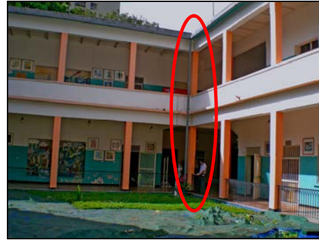
Figura 4.12.13. Vista del patio triangular en el edificio este. Obsérvese la junta estructural
