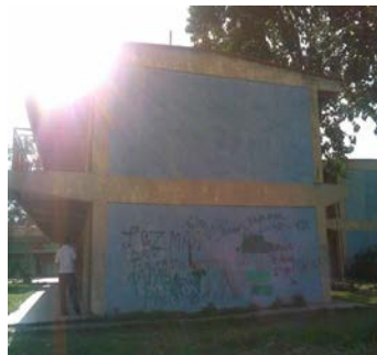
Anexo 4.16.15.- Fachada este del Módulo 3.
