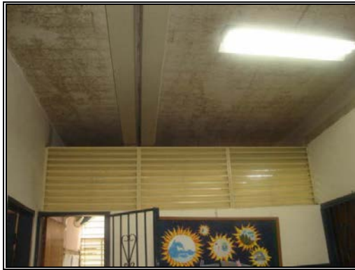
Anexo 4.15.7.- Ventana Interna, planta baja, edificio A.
