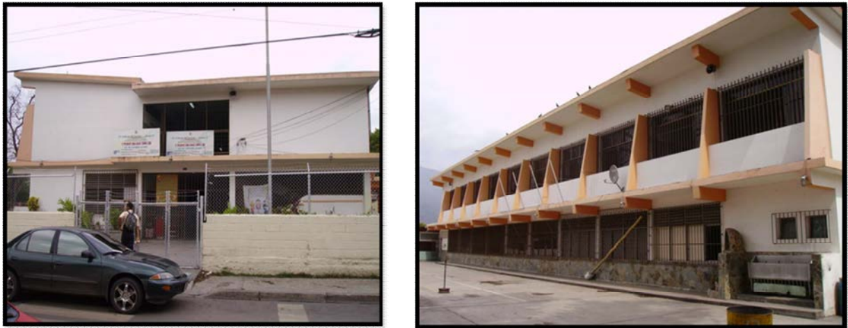
Figura 4.14.1.- Fotografías del Módulo Principal de la U.E. Dr. Lisandro Lecuna, Tipo Antiguo II, Fachada Este (foto izquierda) y Fachada Sur (foto derecha).
