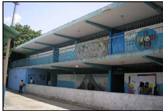
Figura 4.6.40.- Fachada sur del primer módulo.
