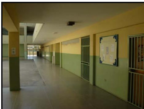
Figura 4.7.5.- Vista de un pasillo de la Corazón de Jesús
