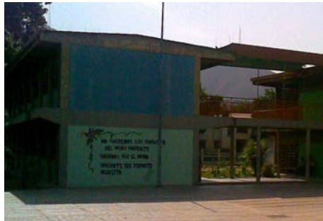
Anexo 4.16.14.- Fachada oeste del Módulo 2.
