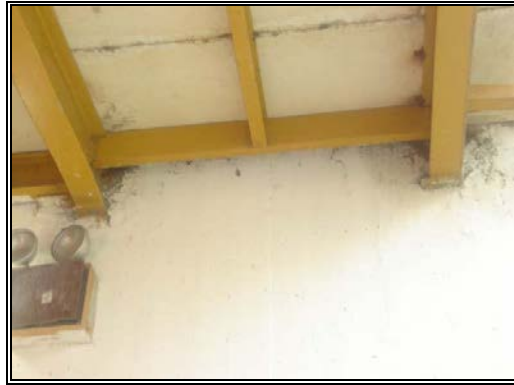
Anexo 4.15.22.- Unión Descanso-Muro, primer piso, edificio A.
