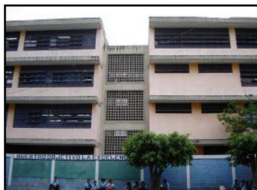
Figura 4.10.5.- Fachada Oeste de la U. E. N. Padre Sojo. Se observan las paredes de ventilación en el módulo de la escalera.
