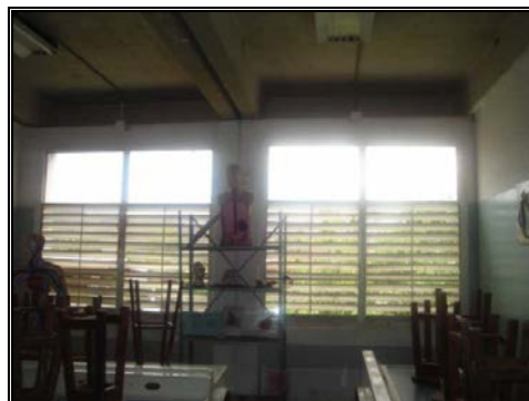
Anexo 4.15.36.- Laboratorio, tercer piso, edificio A.
