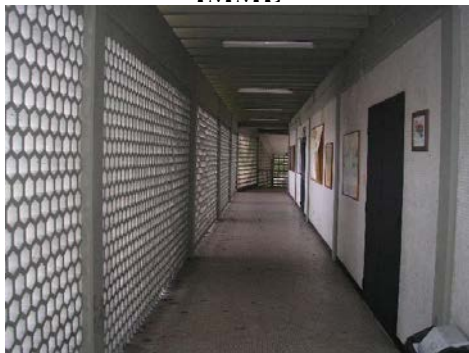
Figura 3.7. Pasillo del segundo piso del Edificio Sur del IMME
