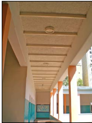
Figura 4.12.14. Vista de un pasillo y de la losa de techo
