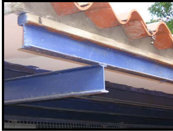
Figura 4.13.14 Edificación 1 Detalle de la cubierta de techo. Apreciarse el espesor del mortero debajo de las tejas
