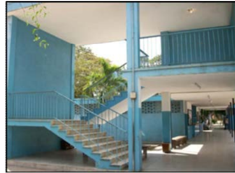
Figura 4.6.6.- Modulo de escaleras
