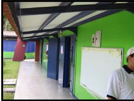
Figura 4.13.17 Edificación 2. Fachada sur
