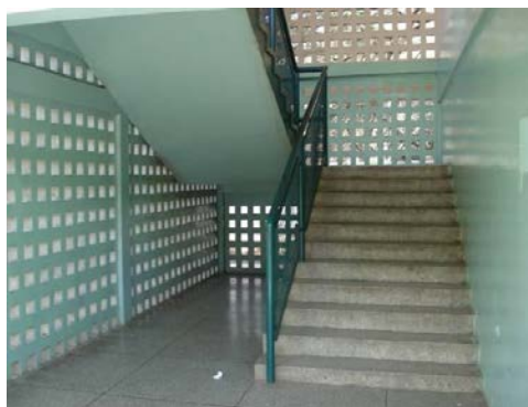
Figura 4.9.5.- Vista de escalera del Módulo 1
