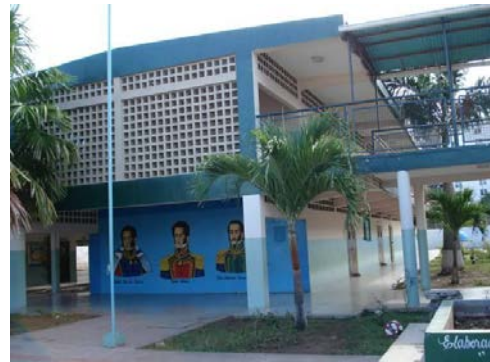
Figura 4.9.4.- Vista Frontal del Módulo 2
