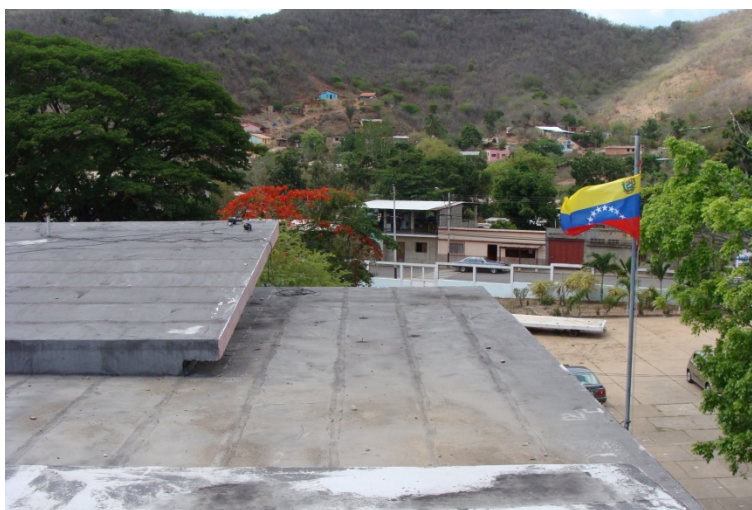
Figura 5.2. 95.- Sensores Ch 5 y Ch 6.
