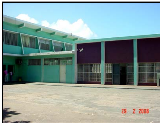
Figura 4.8.6. Módulo Anexo rígidamente conectado al Modulo Principal.
