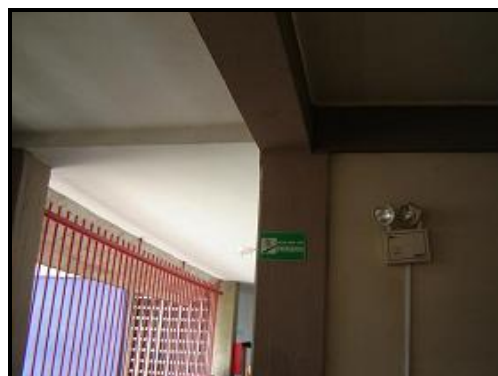
Figura 4.10.23.- Imagen tomada desde el Módulo de la escalera hacia el edificio Sur, donde se aprecian las vigas altas en ambas direcciones y la columna C4.
