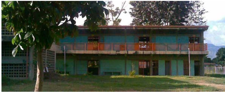
Anexo 4.16.16.- Parte de la fachada sur del módulo. Este módulo, no tiene escaleras, por lo tanto para acceder a su planta alta, se debe hacer por el pasillo que lo comunica con el Módulo 2.
