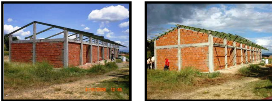
Figura 4.13.33 E.T.I. Cruz Villegas, Estado Miranda
