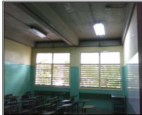
Anexo 4.15.23.- Salón, primer piso, edificio A.
