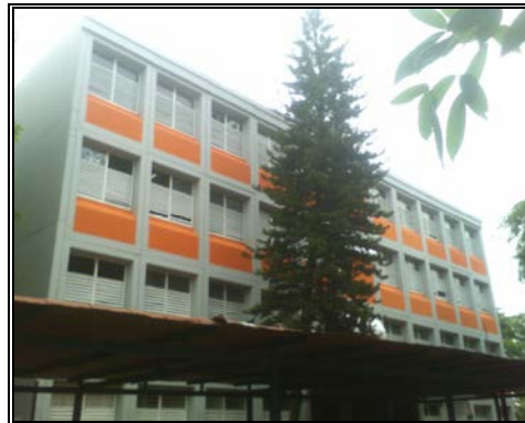
Anexo 4.15.2.- Fachada Sur, edificio A.
