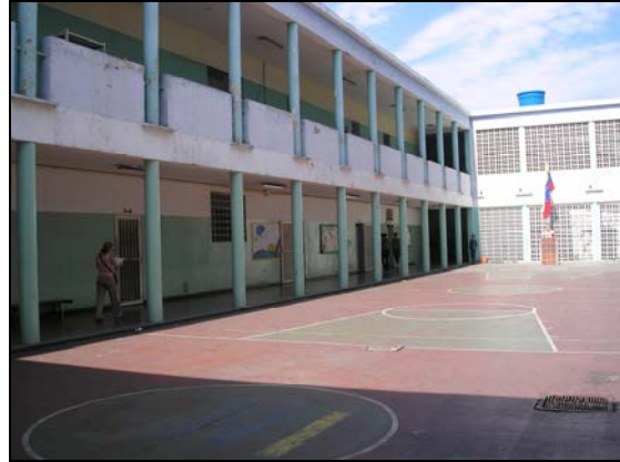
Figura 4.12.4. Vista del patio oeste
