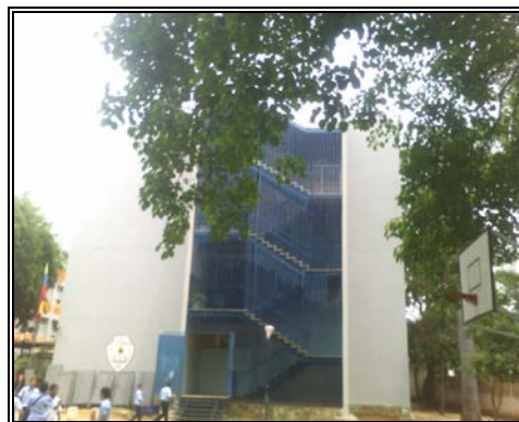
Anexo 4.15.3.- Fachada Este, edificio A.
