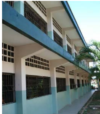
Figura 4.9.11.- Fachada Posterior del Módulo 3.
