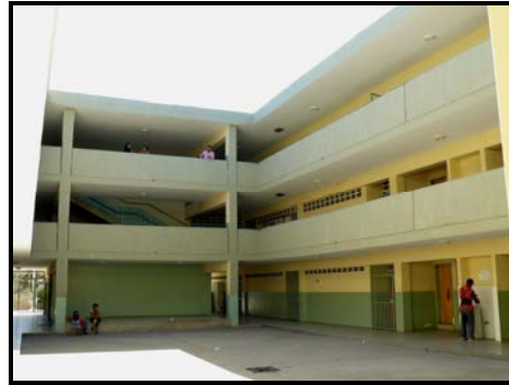
Figura 4.7.4.- Vista desde el patio interno de la Corazón de Jesús
