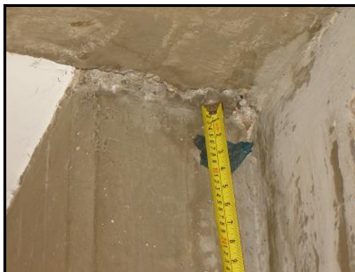
Figura 4.10.52.- Junta del Edificio Norte en la parte inferior de la losa del nivel 2
