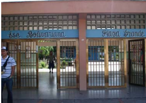
Figura 4.9.1.- Entrada Principal de la Escuela
