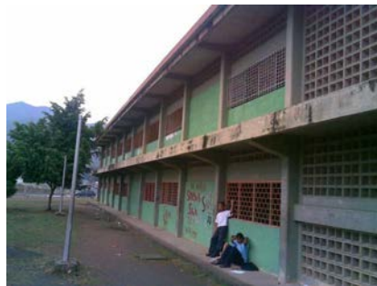
Anexo 4.16.18.- Fachada norte del Módulo 4.
