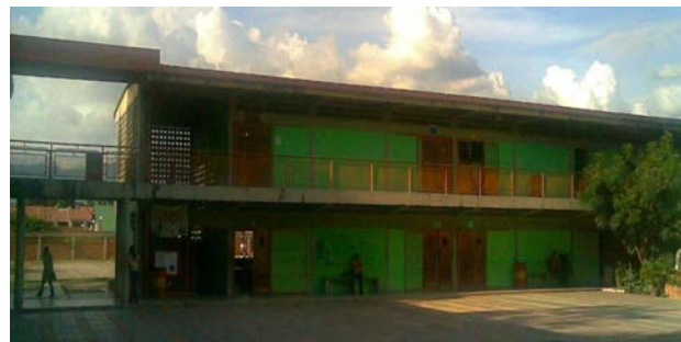
Anexo 4.16.19.- Fachada sur del Módulo 4.
