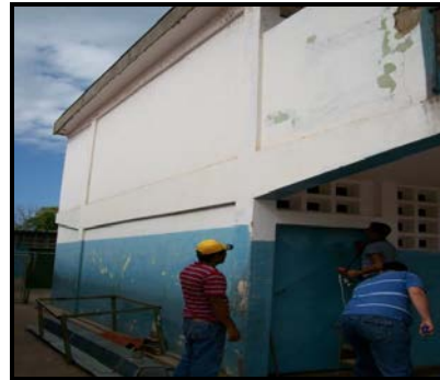
Figura 4.6.17.- Fachada Este y Oeste
