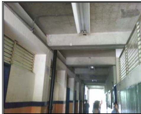
Anexo 4.15.20.- Pasillo, primer piso, edificio A.
