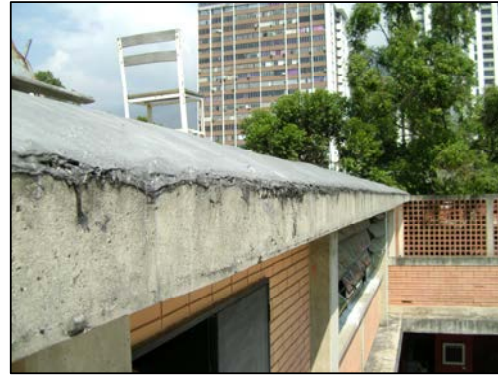
Figura 4.11.7.- Mampostería de bloque tipo tricote / losa del nivel de techo
