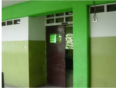
Figura 4.17.10.- Detalle de puerta y ventanas, ala norte.
