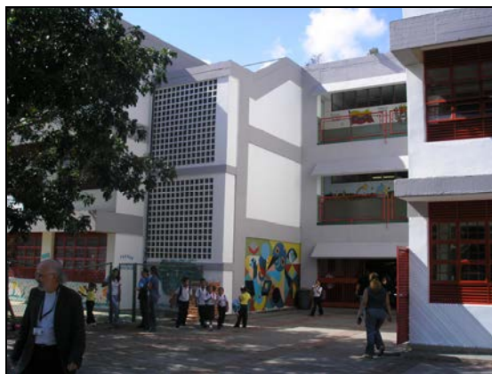
Figura 4.12.8. Vista de la edificación escolar
