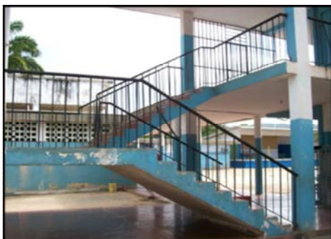
Figura 4.6.18.- Modulo de Escaleras
