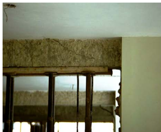
Daños en vigas y losas (Steinbrugge, 1967)
