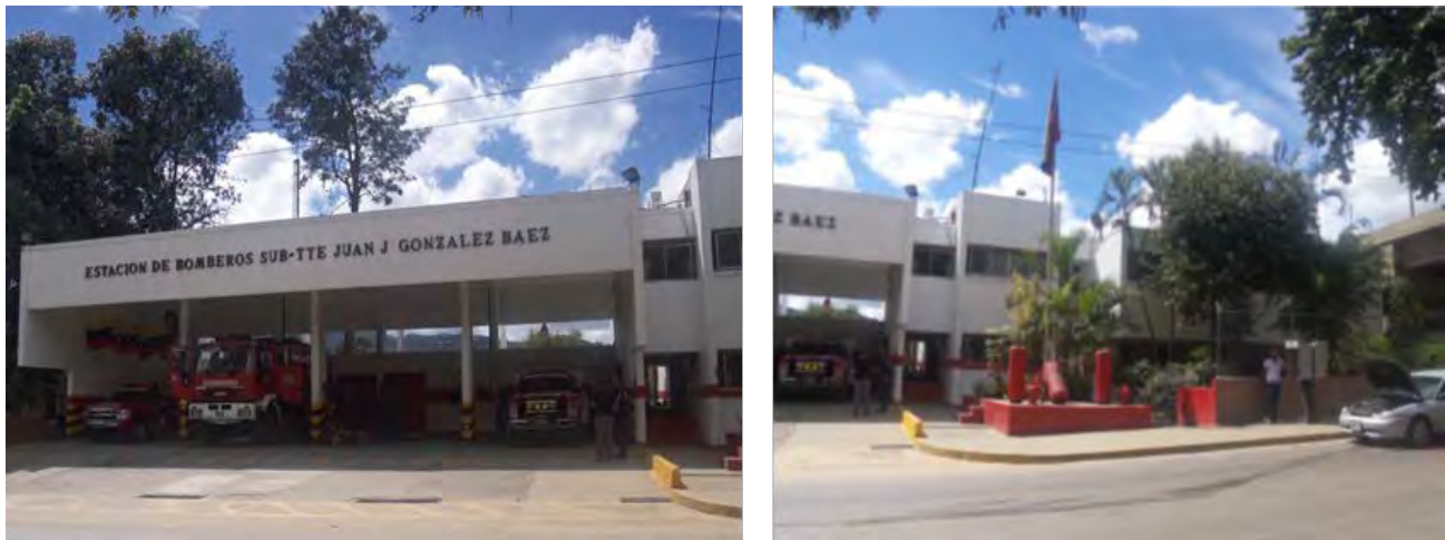
Fachada principal de la Estación de Bomberos de El Valle. Izquierda, modulo de doble altura y escaleras. Derecha, modulo administrativo y dormitorios.
