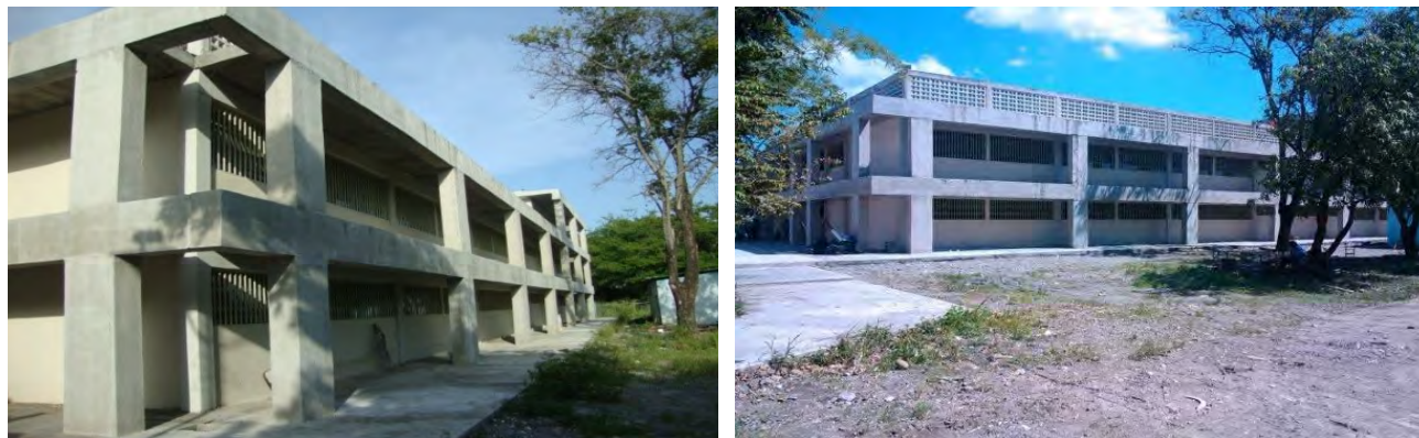
Reforzamiento y rehabilitación Integral de la U. E. “El Libertador”, Edo. Portuguesa. Tipo Cajetón MOP-MINDUR. Proyecto de Refuerzo Estructural Ing. Esteban Tenreiro.
