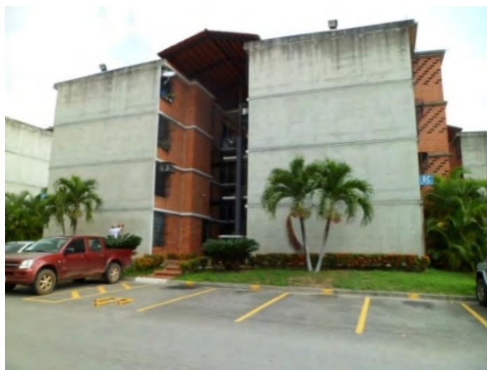
Edificio en Nueva Casarapa, Guarenas- Estado Miranda.
