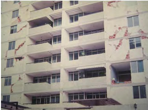
Daño típico en paredes. Izquierda (Fintel et al., 1967): grietas diagonales y en “x”. Derecha (Steinbrugge, 1967): grietas perimetrales en el contacto con el marco
