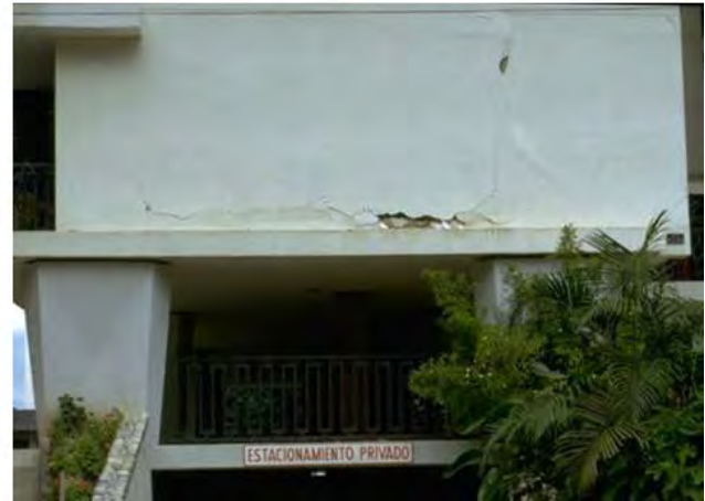
Daño típico en paredes. Izquierda (Fintel et al., 1967): grietas diagonales y en “x”. Derecha (Steinbrugge, 1967): grietas perimetrales en el contacto con el marco
