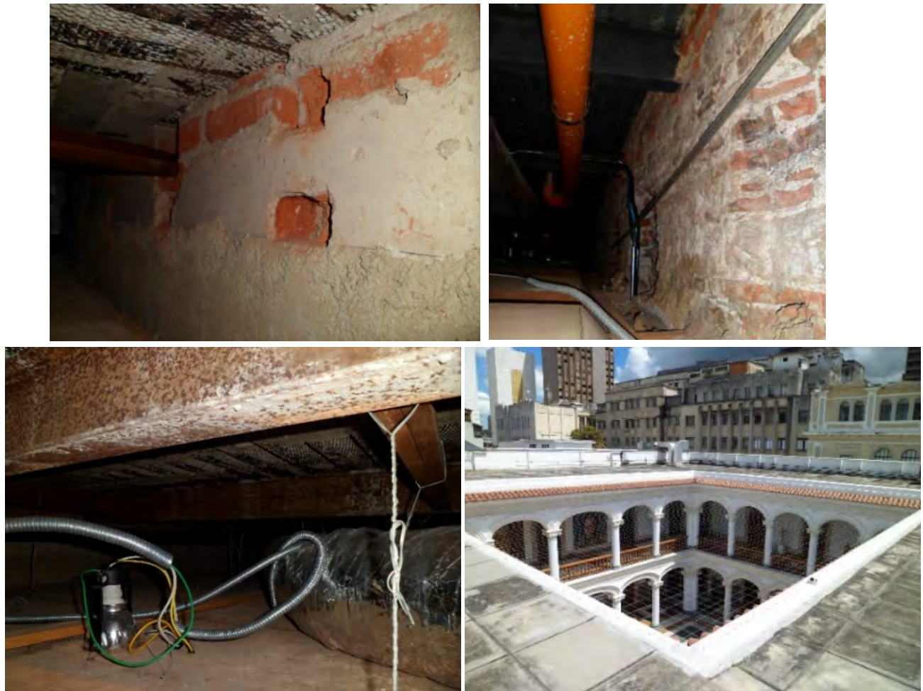
Sistemas de piso y techo de la Casa Amarilla "Antonio José de Sucre".
